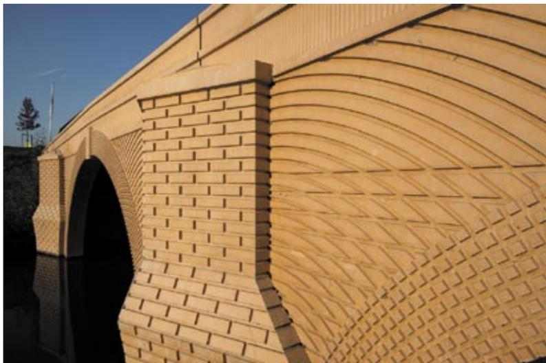
Originalgetreu: Die auf dem 50-Euro-Geldschein abgebildete Brücke wurde aus 23,9 Kubikmetern Beton gegossen und mit 240 Kilogramm Bayferrox-Eisenoxidpigmenten eingefärbt
