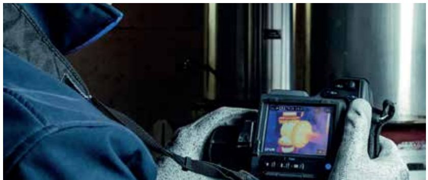
Bilfinger identifiziert Schwachstellen in der Isolierung.
