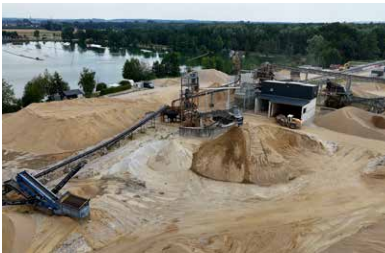
Im Kieswerk werden Sand und Kies gewaschen, gesiebt und nach Korngrößen sortiert.
