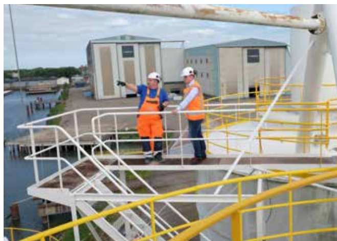
Mit dem Vega Inventory System (VIS) können Kapitäne künftig während des Entladens den Füllstand im Silo nahezu live ablesen.
