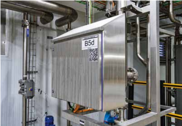
Vorteile der Rittal Edelstahlgehäuse im Hygienic Design: Dachneigung von 30 Grad nach vorne, glatte Oberfläche, rundum außenliegende spaltfreie Silikondichtung
