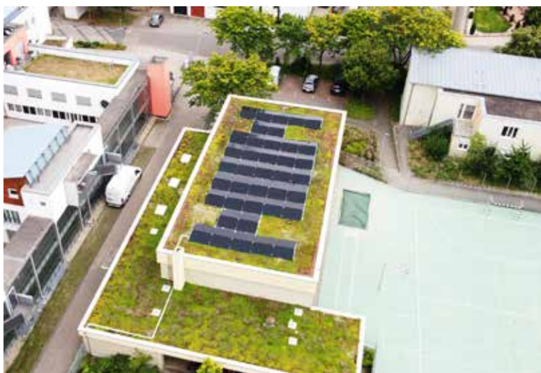
Die bereits installierten acht Anlagen, darunter auch die auf der Turnhalle der Bolandenschule, verfügen über eine Gesamtleistung von 587 Kilowatt-Peak.
