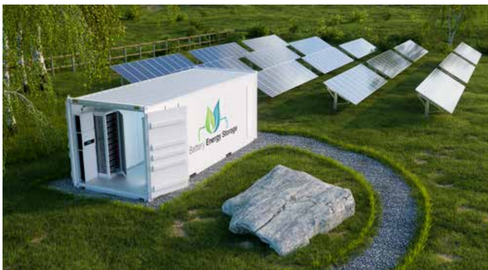
Batteriespeicher als Systemdienstleister: Regelungsfähige Wechselrichter stellen Momentanreserve sowie dynamische Spannungsstützung bereit.
