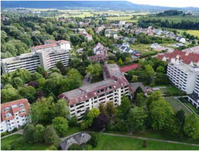
Die Schwarzwaldklinik in Bad Krozingen wurde nachhaltig modernisiert und die erzielten Einsparungen refinanzieren die Investitionen.
