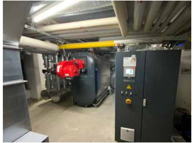
Zu den Modernisierungsmaßnahmen zählte auch der Austausch der Heizkessel, hier in der Fachklinik für Orthopädie.
