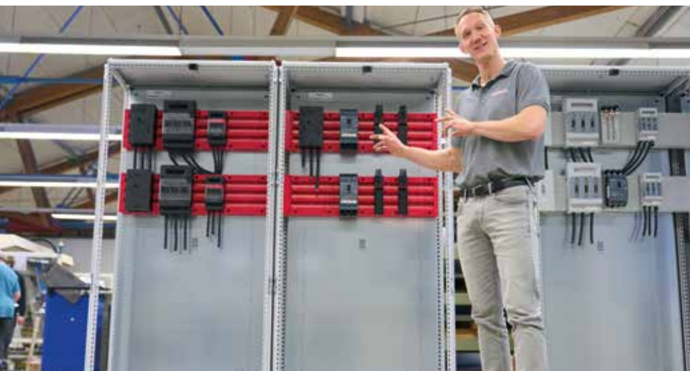
„Wir sparen eine halbe Schicht pro Schaltschrank“, sagt Marcel Birkenberger, Fertigungsleiter bei gefeba.
