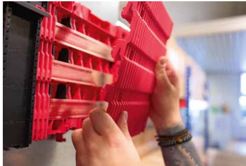
Die Schienen sitzen ohne Halterplanung sicher im Board – mit Berührungsschutz bis IP 2XB oder IP 3X.
