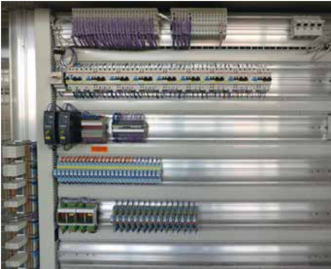
Platzersparnis und Platzreserven für die Zukunft dank AirStream Schaltschrankverdrahtung
