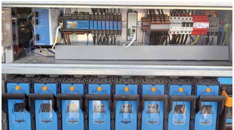
Der modulare Netzanalysator UMG 801 erfasst wichtige Daten über die Auslastung des Netzes.
