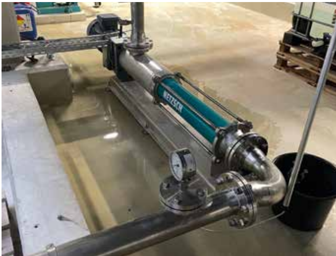
Die Nemo-Pumpe von Netzsch ist eine robuste und effiziente Verdrängerpumpe, die sich ideal für den zuverlässigen Transport viskoser Medien in der Chemie-Industrie eignet.
