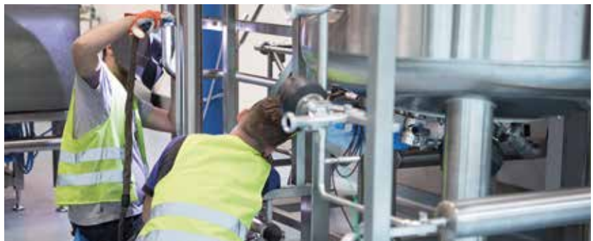
Anlagenmontage und Verkabelung bei einem Pharmakunden.
