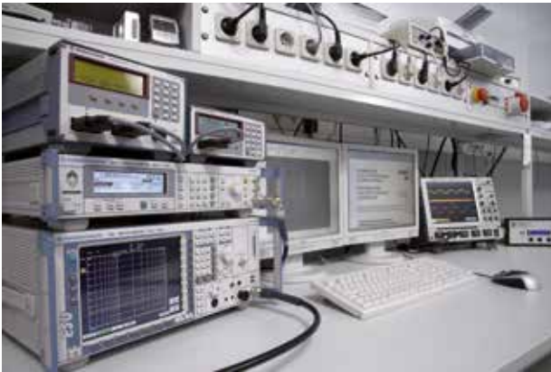
Für die EMV-Tests an unterschiedlichen Systemen und Komponenten wird modernste Messtechnik eingesetzt.
