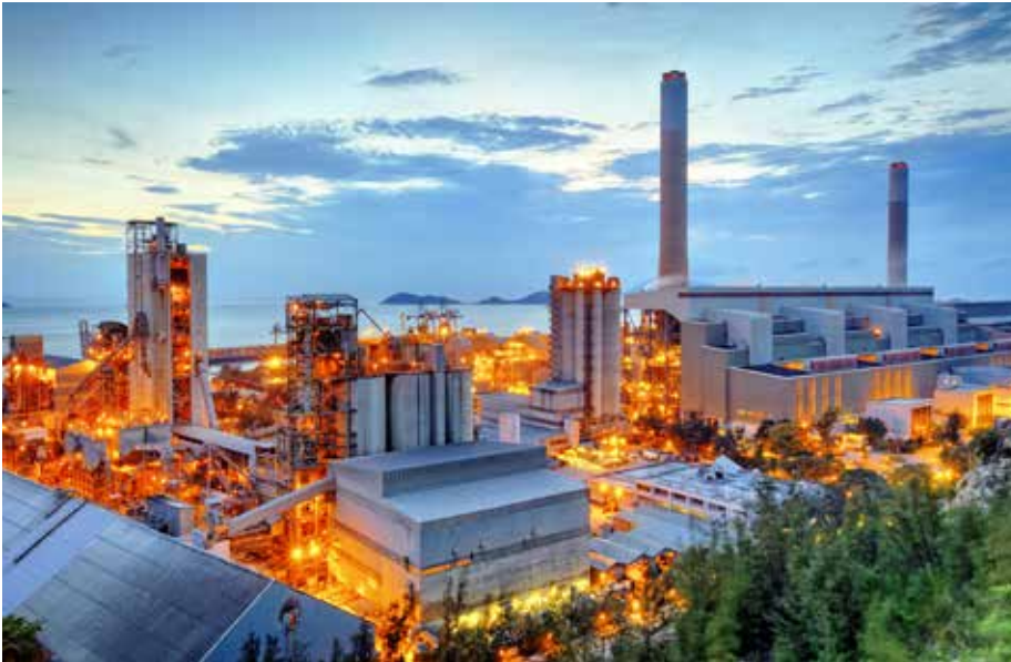
Datenintegration ist der Schlüssel. Nur so können Bestandsanlagen Schritt für Schritt modernisiert werden.
