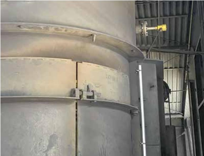
Die Bedingungen rund um den Schachtofen sind rau, die Sensoren von Vega lassen sich jedoch weder von Staub noch von den hohen Temperaturen beeindrucken.
