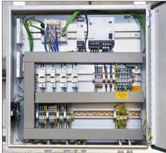
Die Energieversorgung der EP-Box-Module erfolgt dezentral über 27 Schaltschränke mit Beckhoff Stromversorgungen PS3031-2440.
