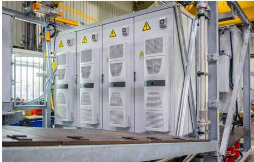
Insgesamt acht IS2 Automationsschränke sind im Einsatz. Diese wurden als Block angereiht sowie Rücken an Rücken montiert, sodass die Gesamtabmessungen bei 2200x3200x1600 mm (HxBxT) lagen.
