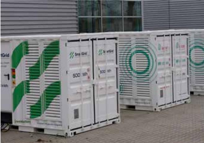
Ein SmartGrid-Batteriespeichersystem im 10-Fuß-Container: Ein vollständig geladenes SmartGrid-500-kWh-Batteriesystem kann genug sauberen Strom für 15 vollständige Ladezyklen eines kleinen Baggers liefern.
