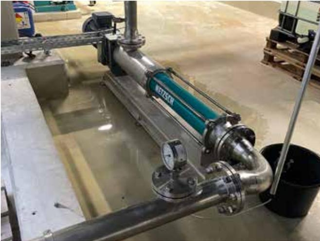
Die Nemo-Pumpe von Netzsch ist eine robuste und effiziente Verdrängerpumpe, die sich ideal für den zuverlässigen Transport viskoser Medien in der Chemie-Industrie eignet.
