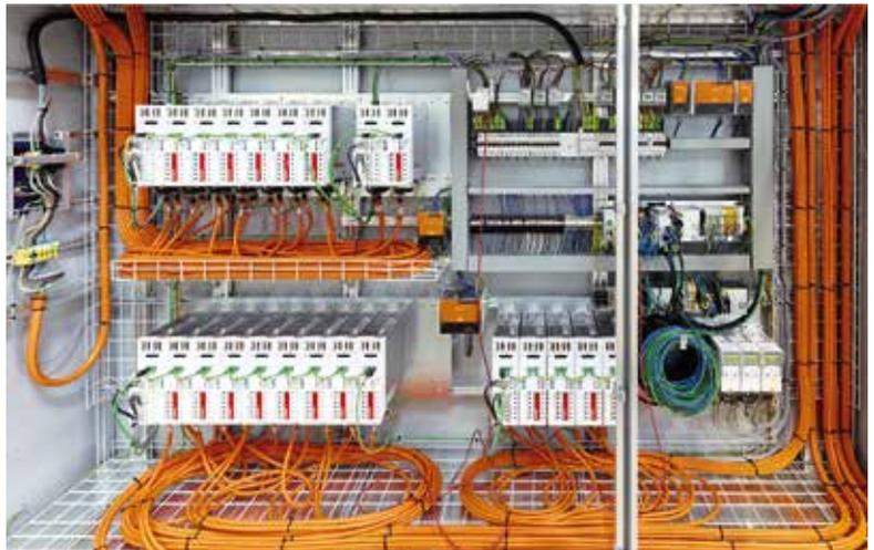
kompakten Bauform und der zahlreichen Kommunikationsschnittstellen sehr gut geeigneten Ultra-Kompakt-Industrie-PCs: je ein C6030 für die Fourcut und die Wiro 500 sowie je ein C6015 für ein optionales Übergabemodul und die OPC-UA-Kommunikation zum übergeordneten Kundensystem.
