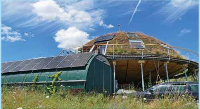
Eine wichtige Energiequelle ist die Photovoltaikanlage, die auf einer langgezogenen Wellblechgarage montiert wurde.
