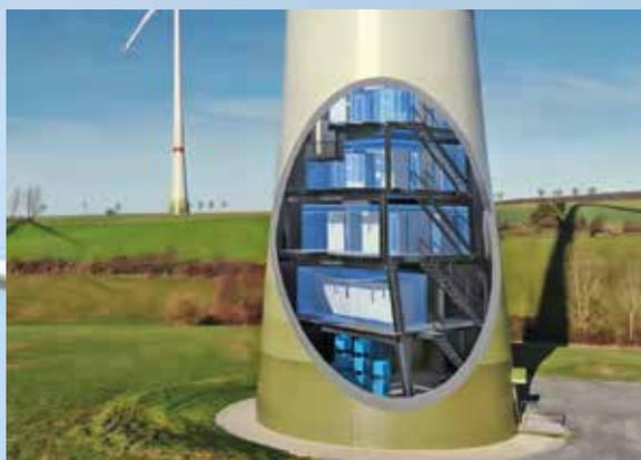
Die Idee ist einfach: Der Strom wird dort genutzt, wo er ohnehin klimaneutral produziert wird – direkt im Windrad. Was vor mehr als zehn Jahren als Experimentalprojekt begann, ist unter der Marke windCORES längst in industriellem Maßstab skalierbar.
