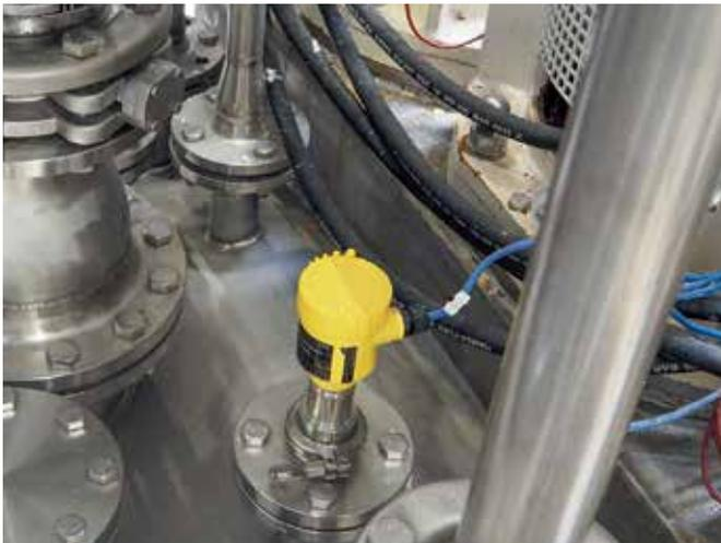
Das Radarfüllstandmessgerät Vegapuls 64 misst zuverlässig den Füllstand in den Produktionsanlagen.
