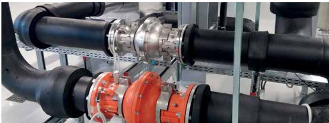
Ventex-Ventile können bei regelmäßiger Wartung mehr als zwanzig Jahre in Betrieb sein. Sie verhindern zuverlässig, dass sich Explosionen über Rohrleitungen ausbreiten.
