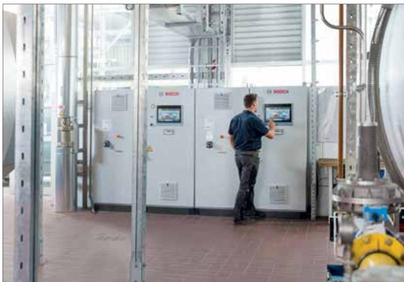
Die Kesselsteuerungen sorgen für einen hohen Automatisierungsgrad und liefern relevante Betriebsdaten an MEC Optimize.
