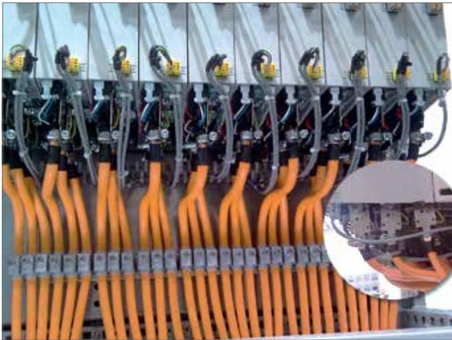
Der Power-Hybrid-Leiterplattensteckverbinder im Einsatz bei einem der derzeit kompaktesten Dreiachsen-Servoregler. Detail: Die Verbindung zu den drei Servomotoren erfolgt über je einen Hybridsteckverbinder.
