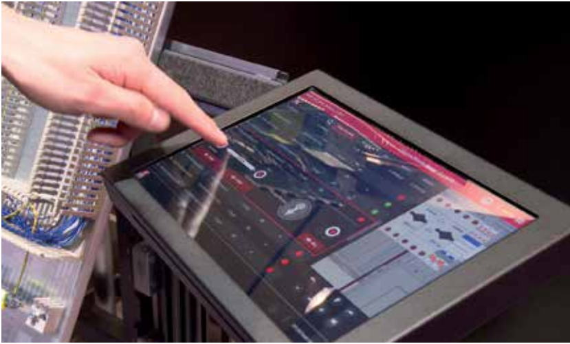
Ein Software-Tool stellt dem Werker Daten zur Schaltschrankverdrahtung auf einem Tablet bereit.
