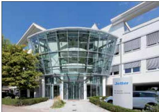
Jetter-Zentrale in Ludwigsburg
