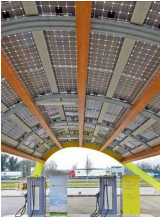
Solarpanels auf dem Dach der einzelnen Ladestationen erzeugen die Energie, die an die Elektroautos abgegeben wird.
