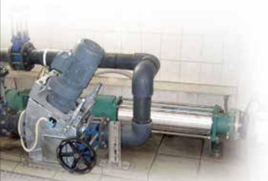
M.Ovas® Zerkleinerer und NEMO® Exzentrerschneckenpumpe
