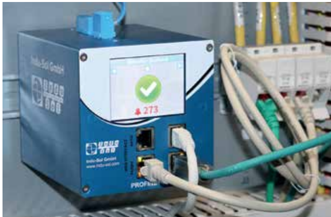
„Stiller Wächter“ im Schaltschrank: Der Profinet-Inspektor-NT zeigt auf dem Display den aktuellen Netzwerkgesamtzustand an und liefert erste Diagnosehinweise.
