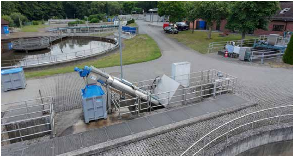
Nachgeschaltete Feinsiebanlage in der mechanischen Vorreinigung: Sie hält feinste Feststoffe zuverlässig zurück und entlastet die biologische Stufe.
