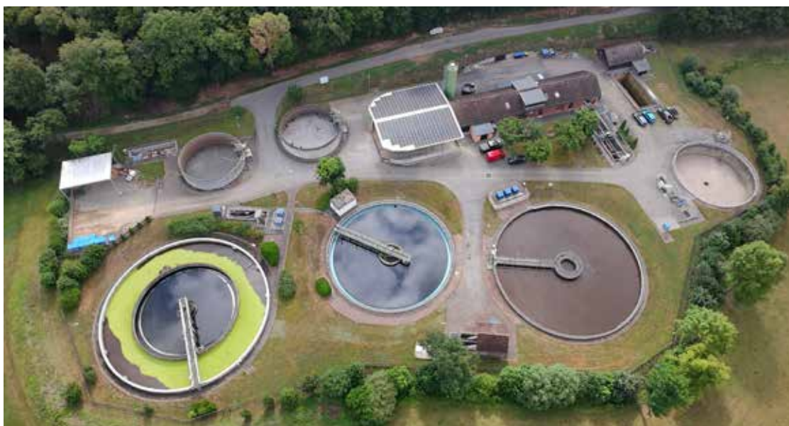
Blick auf die Kläranlage Mühlbachtal: Die Nachrüstung der mechanischen Vorreinigung verbessert die Prozessstabilität der gesamten Anlage.
