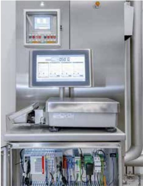
TwinCAT sowie ein Embedded-PC CX5240 (unten) und ein Edelstahl-Control-Panel CP3916 (Mitte) erleichtern die Integration der Daten aller möglichen Systeme, wie zum Beispiel dieser Standwaage, und bilden deswegen das Rückgrat einer cloudbasierten Lösung.
