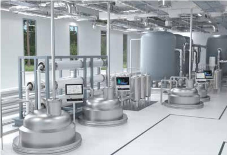
Anlagenbetreiber haben die Möglichkeit, zwischen den Technologien PC, Direct Monitor und auf Thin Clients basierenden Remote Monitoren zu wählen. Remote Monitore eignen sich vor allem für große Anlagen, da sie zentral verwaltet werden können.
