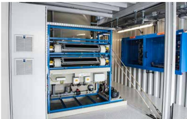
**AOP-Verfahren: Entfernung der Pharmawirkstoffe (API) mittels UV und Wasserstoffperoxid.**
