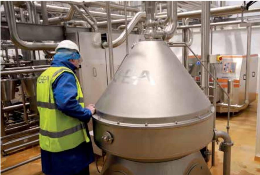
GEA Separator vom Typ MSI 400 mit integriertem Direktantrieb zur Milchenträumung sowie GEA Homogenisator vom Typ Ariete NS 3110 H im Hintergrund.
