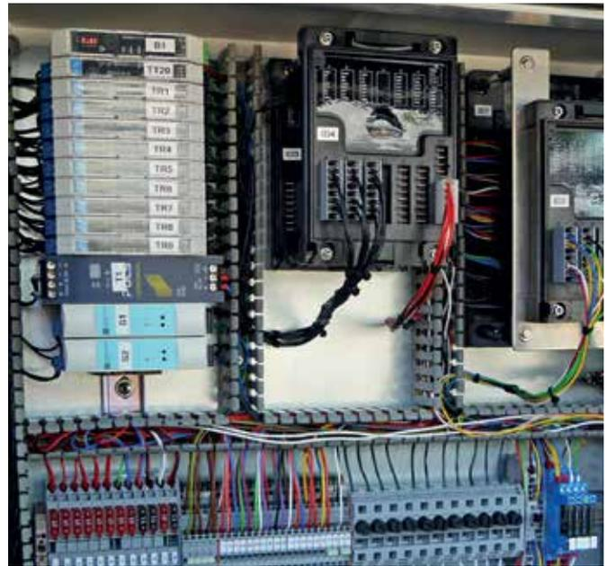
Die neuen 12-mm-Module der Trennstufenreihe ISpac (oben links) sind sehr kompakt und benötigen 30 Prozent weniger Raum.
