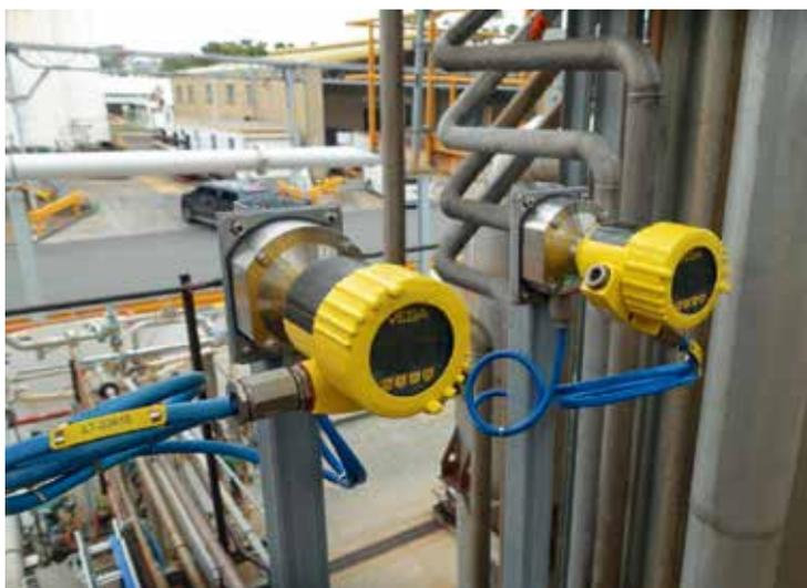
Die Lösung bei stark schwankenden Umgebungstemperaturen ist die elektronische Differenzdruckmessung mit zwei Druckmessumformern.
