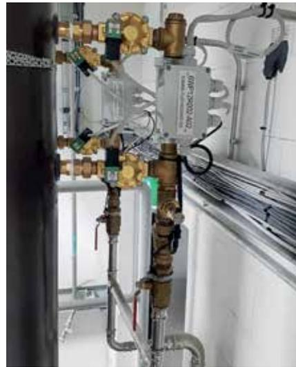
Ein Einsatzbereich der Löschautomatik sind Kunststoffabsaugleitungen.
