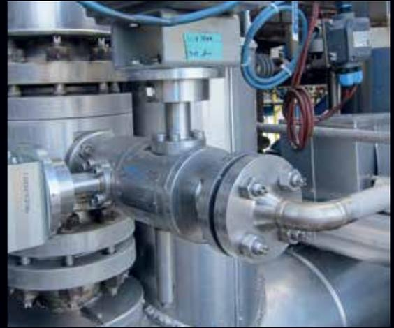
Gasdicht unter extremen Bedingungen: Metallisch dichtende Sauerstoff-Kugelhähne bei Yara
