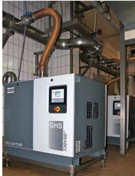
Die Schraubenvakuumpumpen versorgen die Verpackungsanlagen mit einem bedarfsge- rechten Vakuum.
