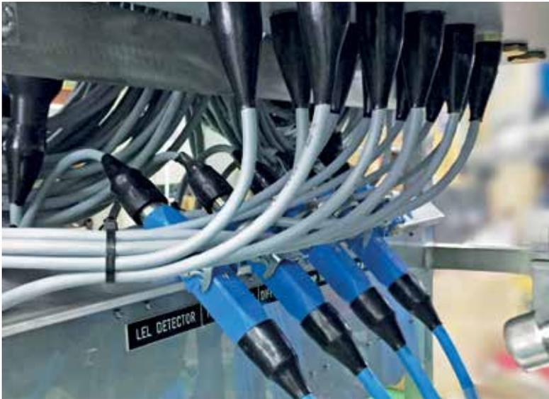
Han-Ex-Steckverbinder für Equipment im explosionsgeschützten Bereich einer Schaltanlagenfertigung
