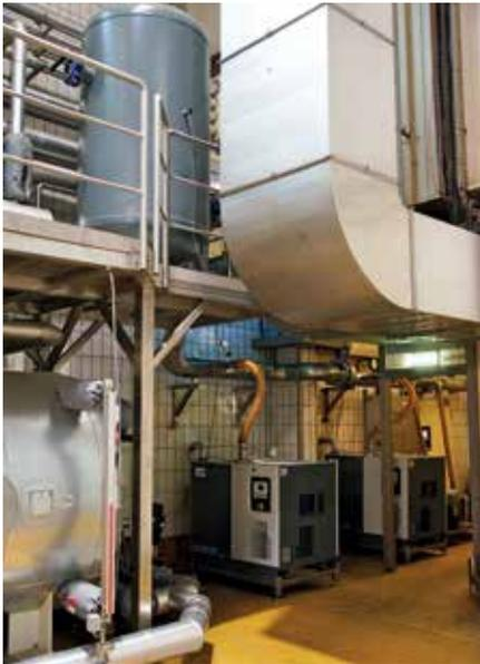
Mit dem 2.000-Liter-Pufferspeicher im Vakuumnetz lassen sich Bedarfsspitzen nach Produktionsstopps direkt bedienen.
