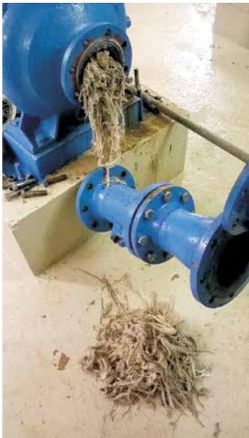
In der Toilette entsorgte Feuchttücher verstopfen mit der Zeit die Kreiselpumpen, die das Abwasser zur Kläranlage transportieren.
