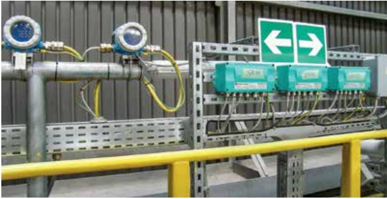
Digitale Kommunikation so einfach: Ein zusätzliches Messgerät benötigt unabhängig von Art oder Messbereich lediglich einen offenen Anschluss am Feldbusverteiler.
