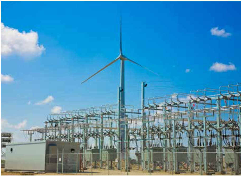
Redispatch 2.0 dient der vorausschauenden Vermeidung von Netzengpässen und sichert die Stabilität des Stromnetzes..
