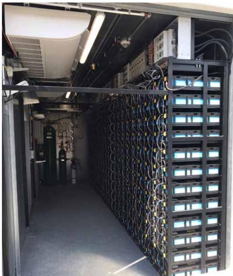
Aufgrund der hohen Brandschutzaufgaben des FZJ wurde die eigentliche Batterie in einem zweiten, kleineren Container untergebracht. Die Löschanlage befindet sich hinten im Container. Rauchansaugsystem und Punktmelder sind ebenfalls installiert sowie zwei Klimaanlagegeräte.
