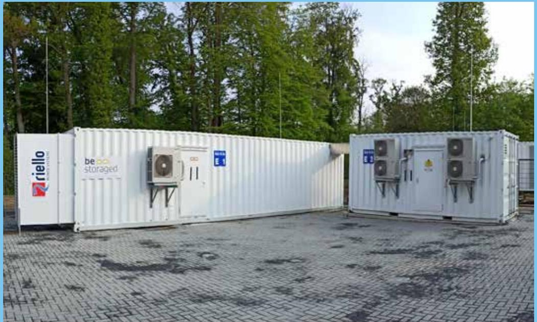
Zu den LLEC-Komponenten, die erprobt werden, gehört unter anderem ein Batteriesystem mit einer Kapazität von 525 kWh und einer Gesamtleistung von 1.500 kW, das angeschlossenen Gebäuden eine redundante unterbrechungsfreie Stromversorgung bietet.
