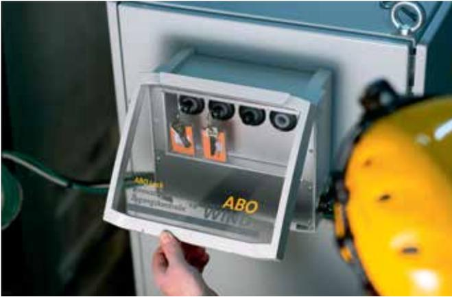
Im Schlüsselschrank befinden sich – elektronisch gesichert – die Schlüssel zu einzelnen Bereichen der Windkraftanlage.
