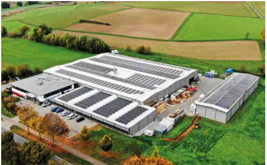
Frenger Systemen BV Heiz- und Kühltechnik im hessischen Groß-Umstadt hat über Jahre hinweg ihren Energieverbrauch optimiert.
