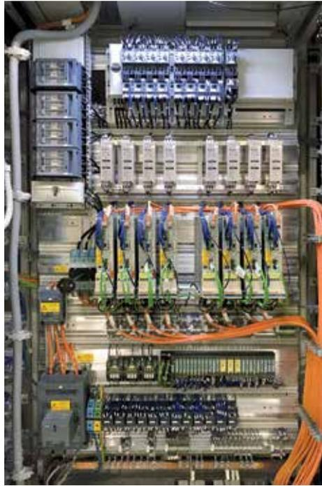
Blick in die Schaltschrank-Versuchsaufbauten bei Audi Hungaria in Győr: rechts mit Airstream-Verdrahtungsrahmen und links mit konventioneller Montageplatte.
