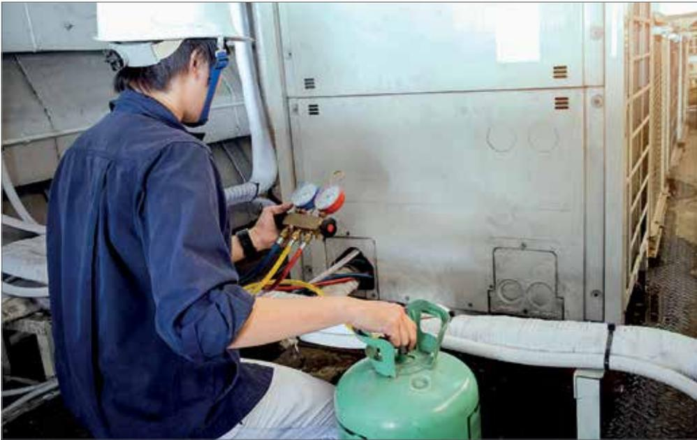
Das CO<sub>2</sub>-Äquivalent einer Anlage entscheidet darüber, ob eine regelmäßige Dichtheitsprüfung und ihre Dokumentation gesetzlich vorgeschrieben sind.
