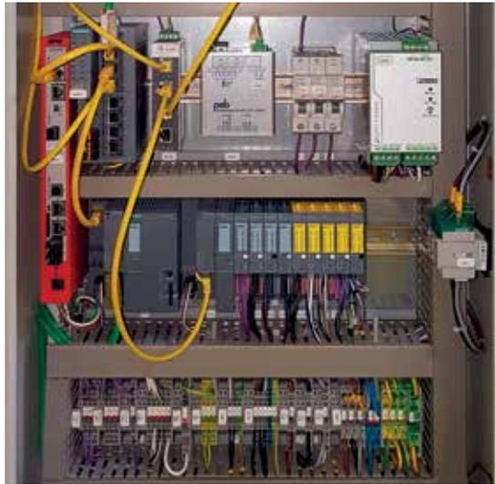
In Schaltschränken müssen bis zu zwei Meter eines Kabels abgemantelt werden, um die Adern dort einzuziehen.
