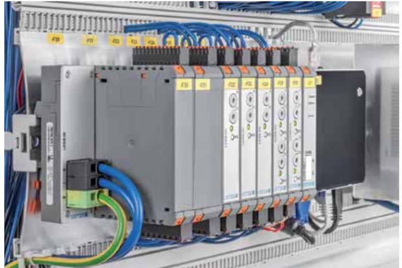
Verdrahtung ohne Kabelkanäle für eine freie Luftzirkulation
