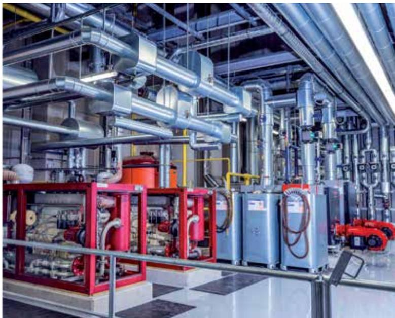
Comuna-Metall vernetzt BHKWs mit IIoT-Gateways von Insys icom und macht sie damit hochverfügbar für Fernwartung und Condition Monitoring.
