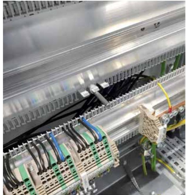
Ein Wärmesensor (Bildmitte) dient zur Steuerung des Airblower-Schalterschranklüfters.
