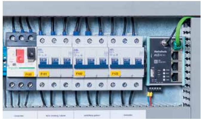
Der Industrierouter REX 100 von Helmholz mit integrierter 3G-Funktionalität kommt im Schaltschrank des Kranes zum Einsatz.
