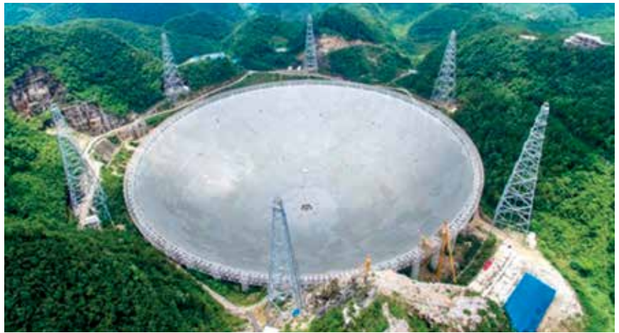
Das Radioteleskop FAST im Kreis Pingtang in Chinas südwestlicher Provinz Guizhou hat mit 520 Metern Durchmesser den Hauptspiegel mit der weltweit größten Fläche.
