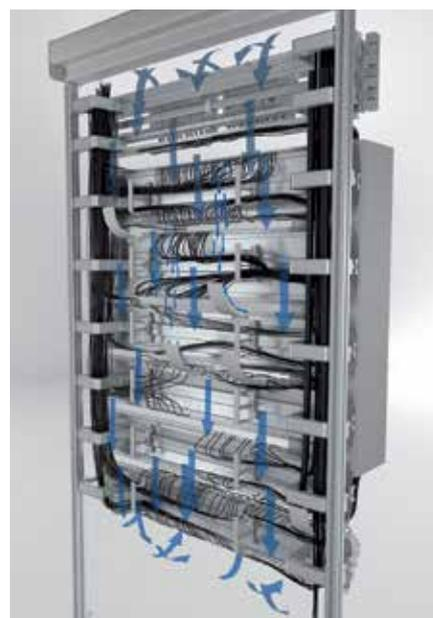
Das Airstream-Verdrahtungssystem sorgt für eine intelligente, strömungsreiche Luftführung, die trotz kompakter Bauweisen Wärmestaus der Verlustwärme gezielt vermeidet (Ansicht von hinten).
