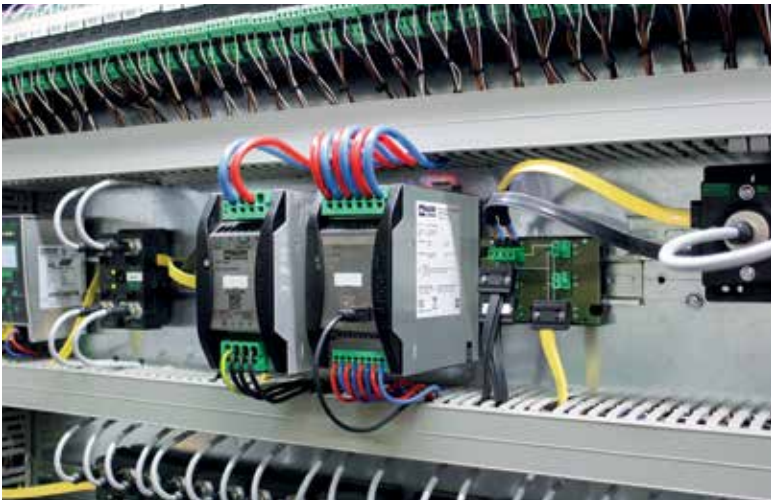
Das USV-Modul sorgt verlässlich für eine unterbrechungsfreie Stromversorgung.
