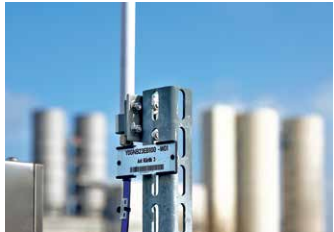
Gut lesbare Markierungen in Verbindung mit flächendeckendem W-LAN auf dem gesamten Betriebsgelände helfen nicht nur Mitarbeitern von externen Unternehmen.
