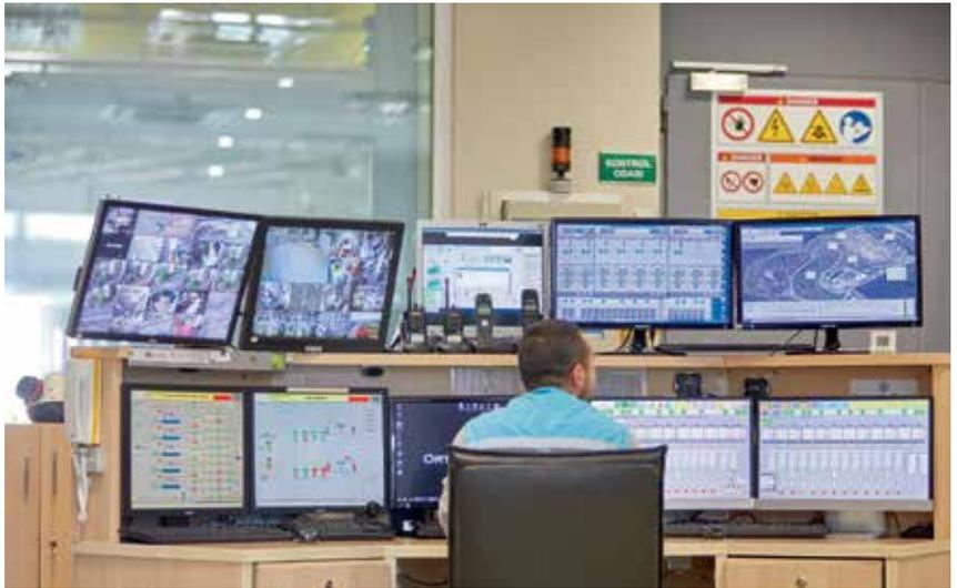
Auf dem Dashboard im Kontrollraum werden die Wasserstände, der Gasdruck und die Funkverbindung live überwacht und aufgezeichnet.
