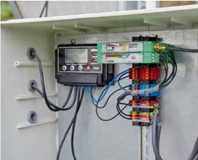
Die in den Schaltkästen nahe den Bohrlöchern verbauten Radioline-Module lassen sich in Zone 2 einsetzen.
