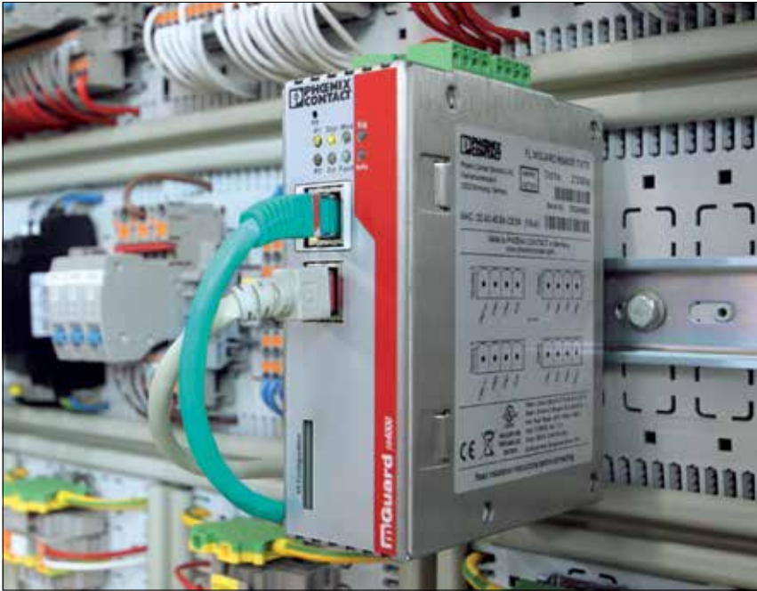
Die Security Appliances FL mGuard, die speziell für OT-Netzwerke entwickelt wurden, schützen Anwendungen vor unbefugten Zugriffen.
