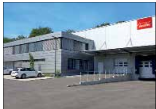
Technologie- und Logistikzentrum in Reutlingen
