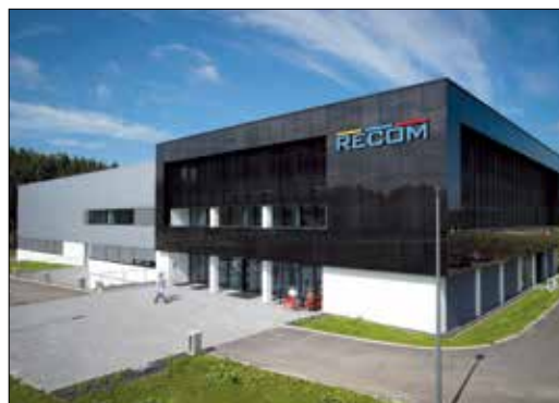
Die neue Unternehmenszentrale in Gmunden / Österreich wurde 2014 neu eröffnet
