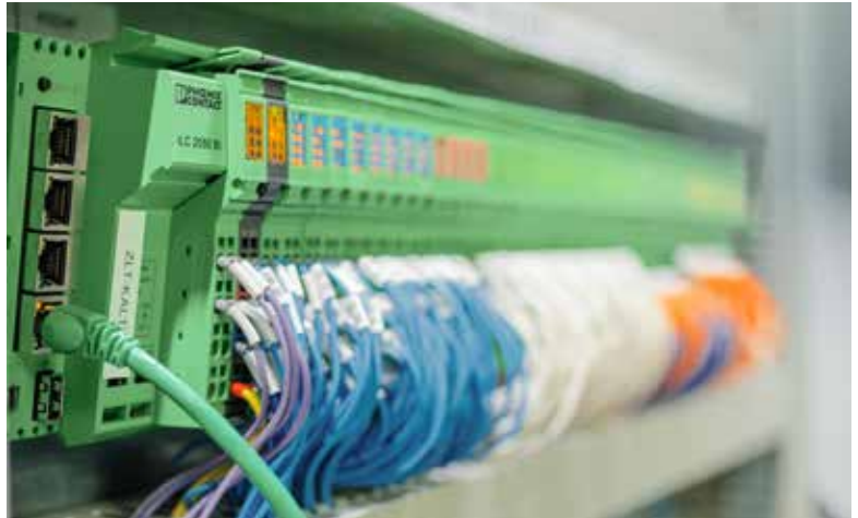
Der IoT-Controller ILC 2050 BI dient als Protokoll-Gateway.
