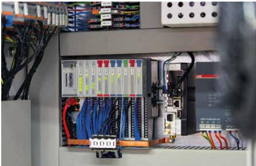
über I/O-Technik, Steuerung mit Visualisierung bis zur Cloud-Anbindung. Die kompakten Turck-PT-Drucktransmitter erfassen präzise den Druck im System und geben die Werte an das modulare BL20-I/O-System und von dort in den Edge Controller TX700 weiter. Dort erfolgt die Überwachung und Steuerung der Eingangs- und Ausgangssignale sowie die Anbindung an die Cloud. Das TX705-HMI dient schließlich als Bedieneinheit mit Visualisierung der Prozesse.
