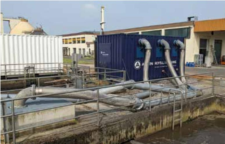
Im Mittelpunkt der mobilen Mietlösung von Aerzen Rental steht ein Container mit drei Turbogebläsen. Jedes Gebläse versorgt ein Belüftungsbecken bedarfsgerecht mit Sauerstoff.
