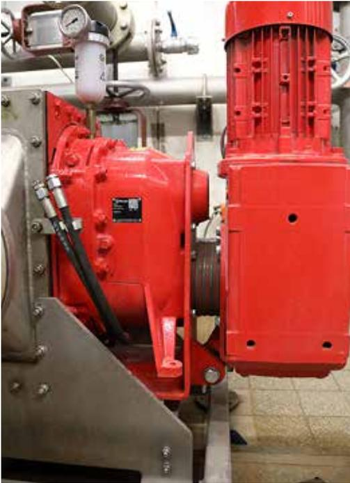
Dank des Antriebs mit Kegelradtriebemotor konnte der XRipper XRP problemlos unterhalb der Druckleitung installiert werden.
